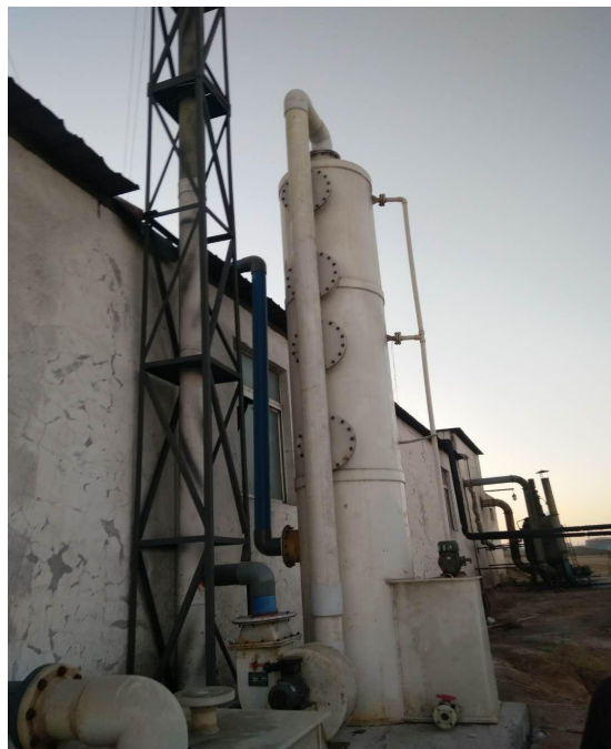
图4-2 硫卡粗制工段碱液吸收塔
