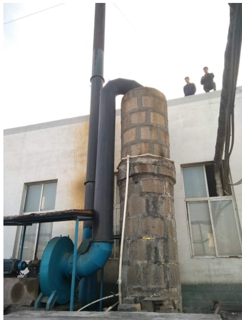
图4-1 锅炉两级麻石水浴+碱液脱硫
